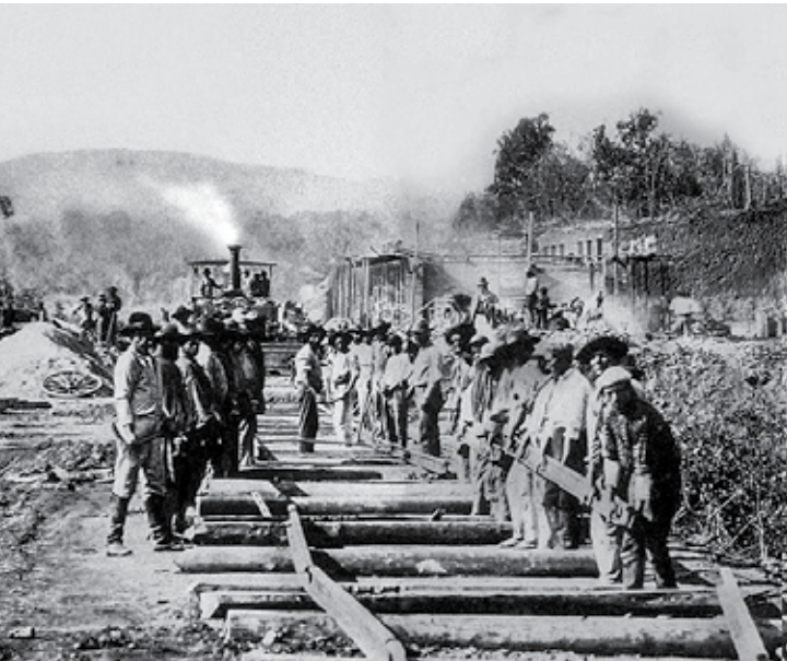
Dezenas de homens durante trabalho braçal na construção das primeiras ferrovias
